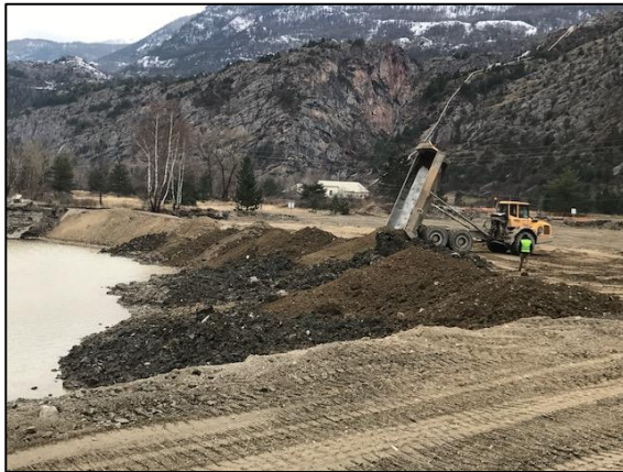
Remblaiement du site (campagne 2017-2018 phase 1)
