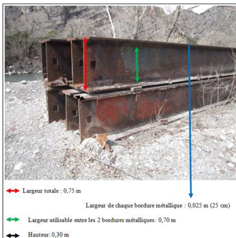
Figure 4. Structure IPN servant au franchissement de la Durance
