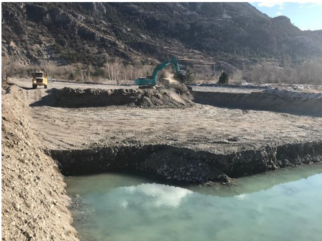
Extraction avec une pelle : 3 mètres hors d'eau + 2 mètres en eau,
