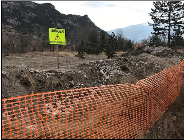
Mise en sécurité du site
