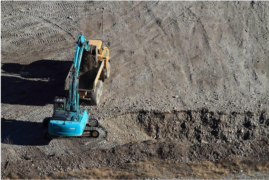
Extraction avec une pelle : 3 mètres hors d'eau + 2 mètres en eau,
